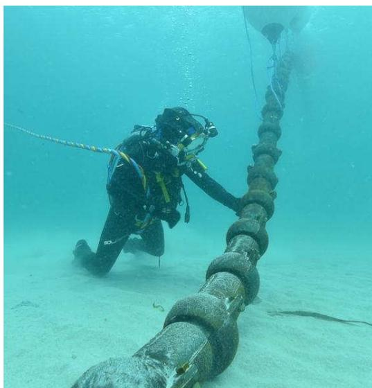
Figura 18: Esempio di metodo di posa con gusci di protezione
