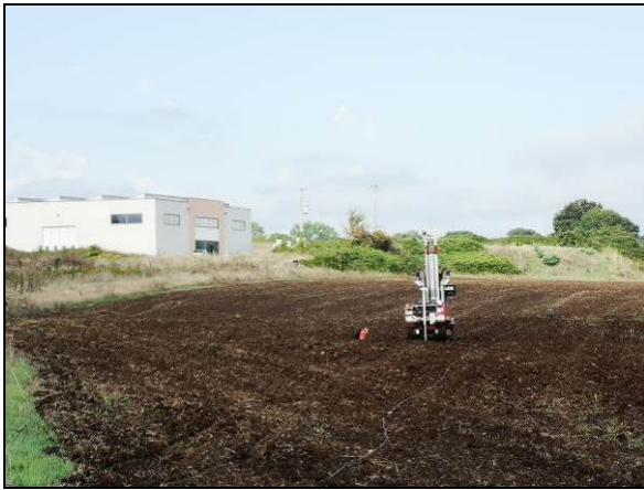
Sondaggio penetrometrico SP3
