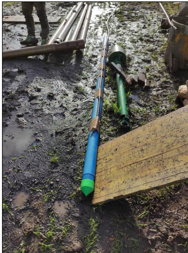
Primo tratto del tubo cieco in PVC durante la predisposizione del rivestimento.
