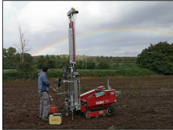
Sondaggio penetrometrico SP7
