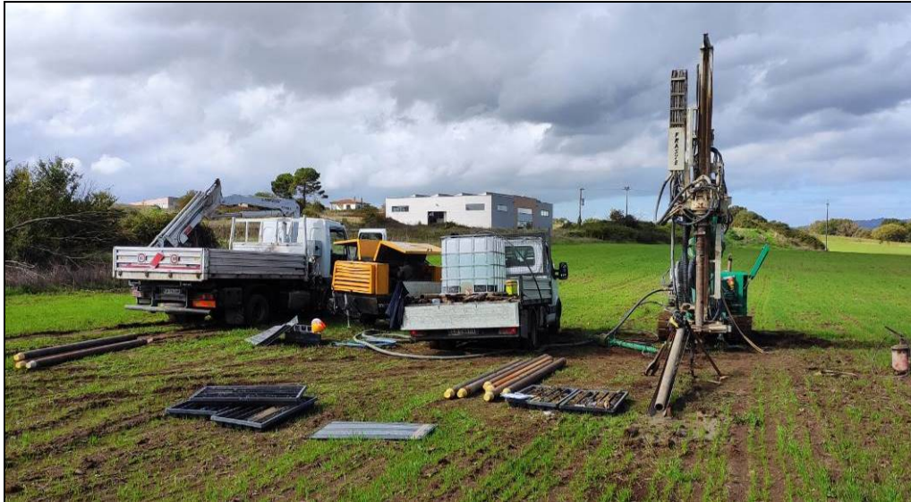
Realizzazione perforazione S1
