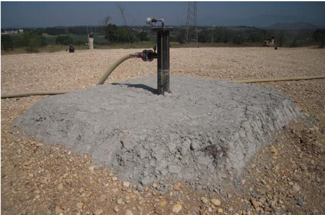
**Figura 18: Particolare della sigillatura sommitale di un pozzo di estrazione del biogas**
