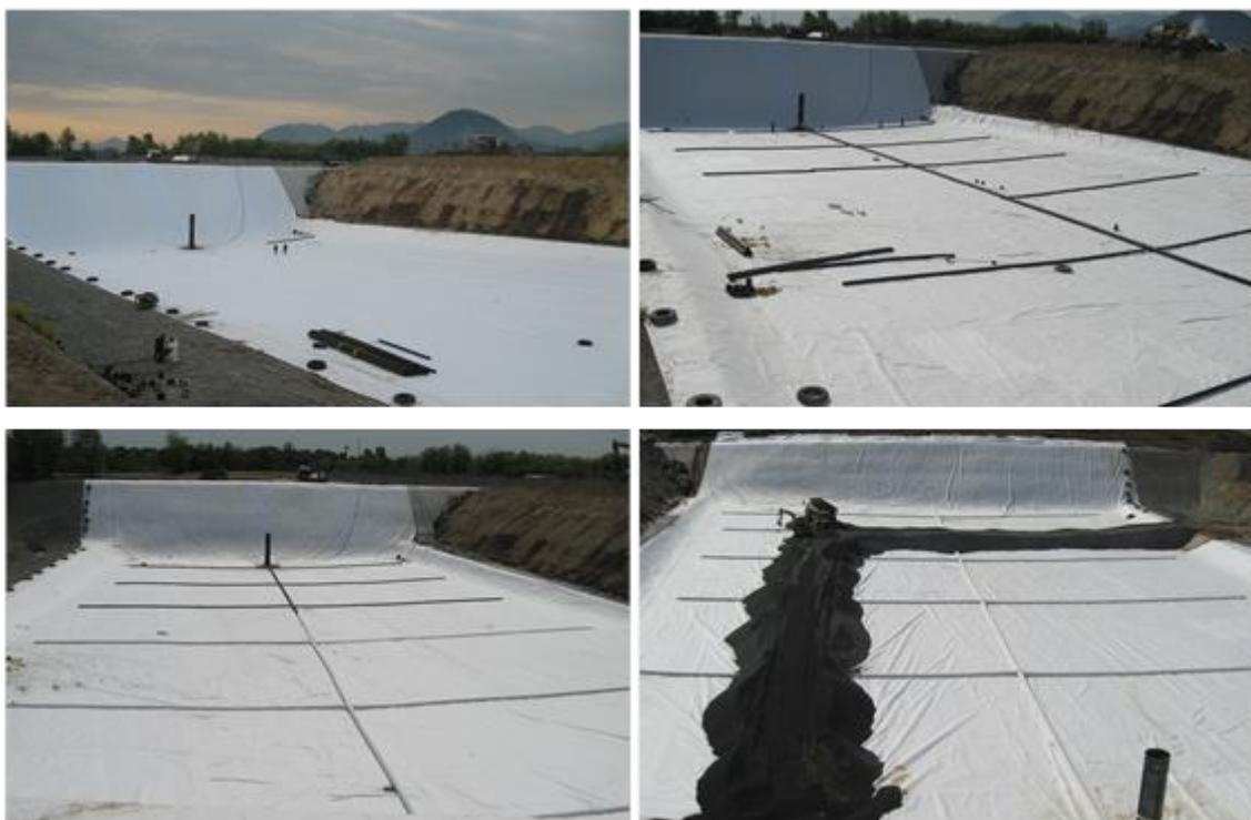
**Figura 11: Fasi realizzative del sistema di collettamento del percolato**
