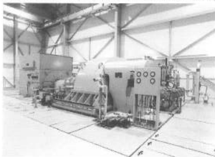
Figura 10 - Turbina da 20MW in esercizio nella centrale di Fukuyama
